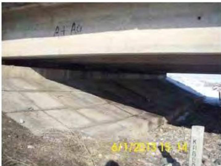
**Рис. 6: Пример укрепления откосов для моста через р. Кара-Ункур**
