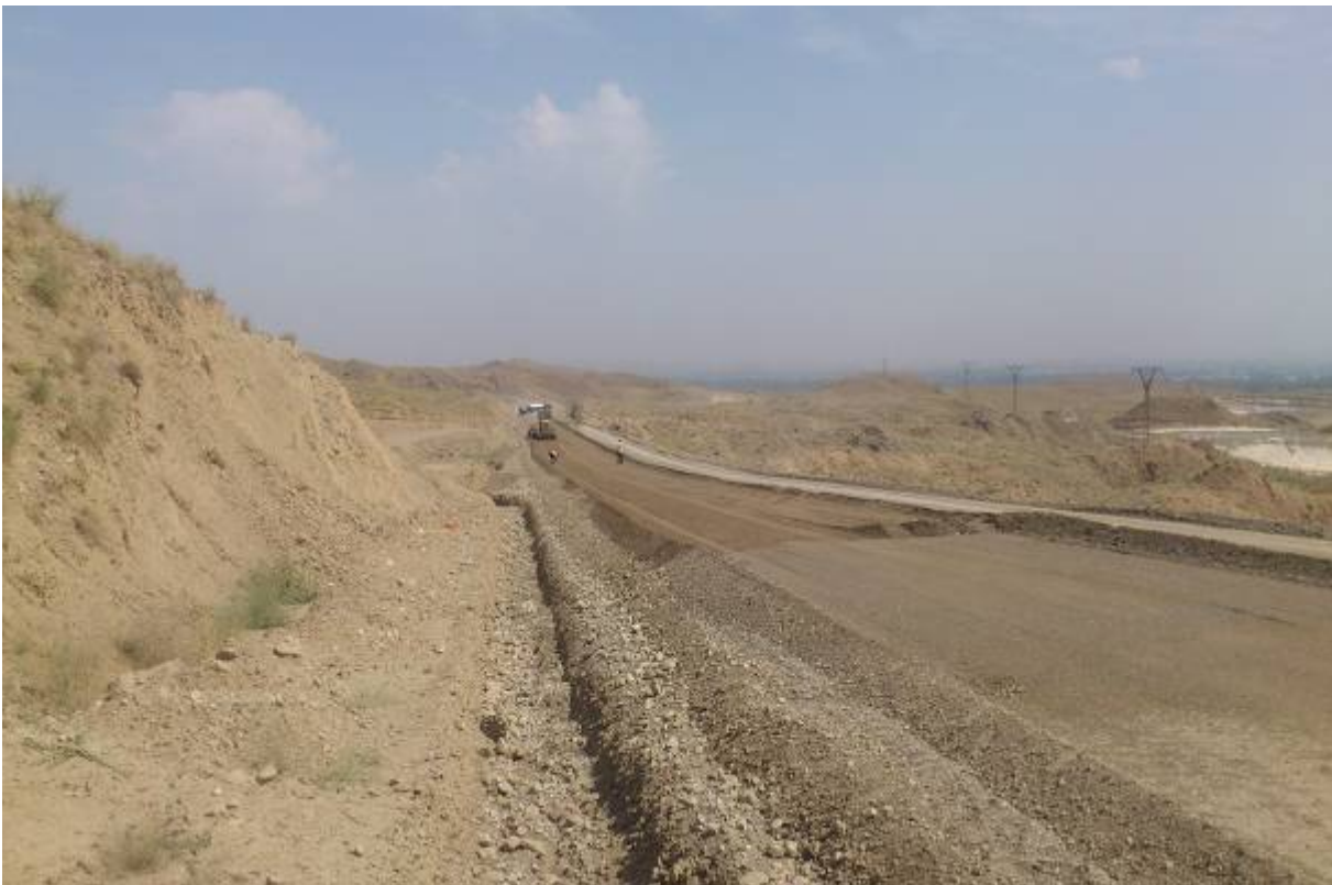
Укладка слоя основания на км 128+400 ПС
