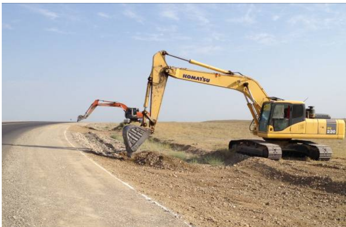
Профилирование дорожных откосов на км 154+100 ПС
