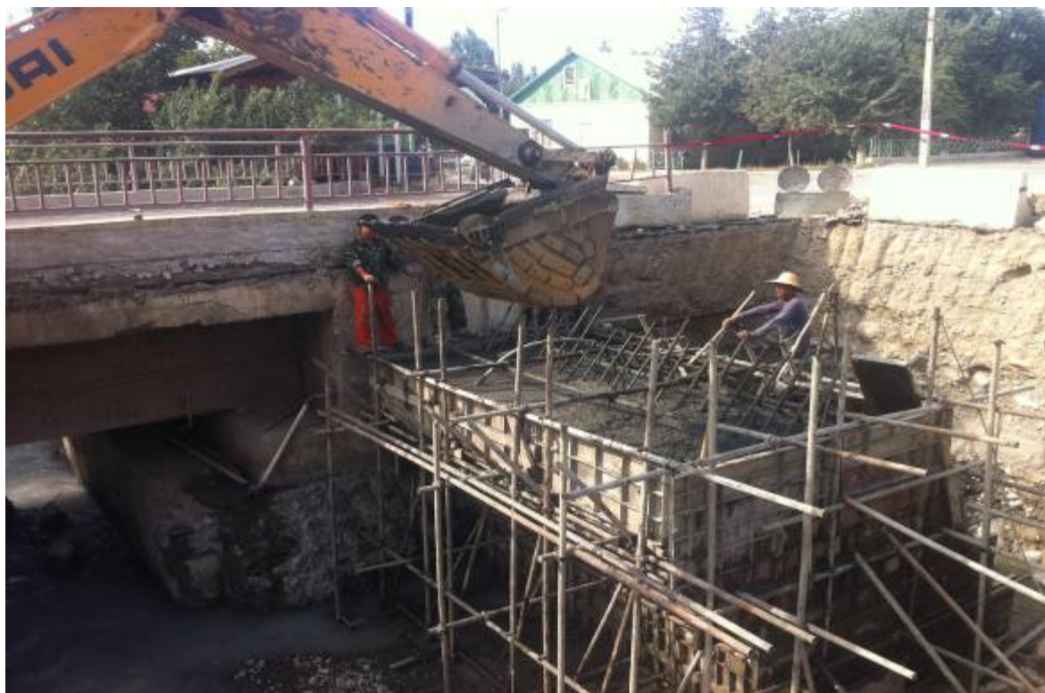
Монолитный бетон для опоры моста на км 124+220 ЛС
