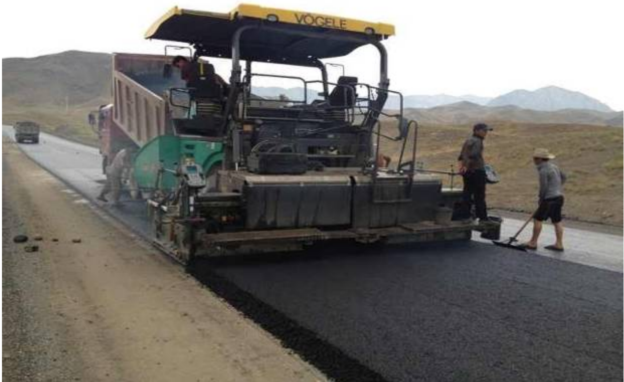
Укладка асфальтового слоя износа 129+400 ПС
