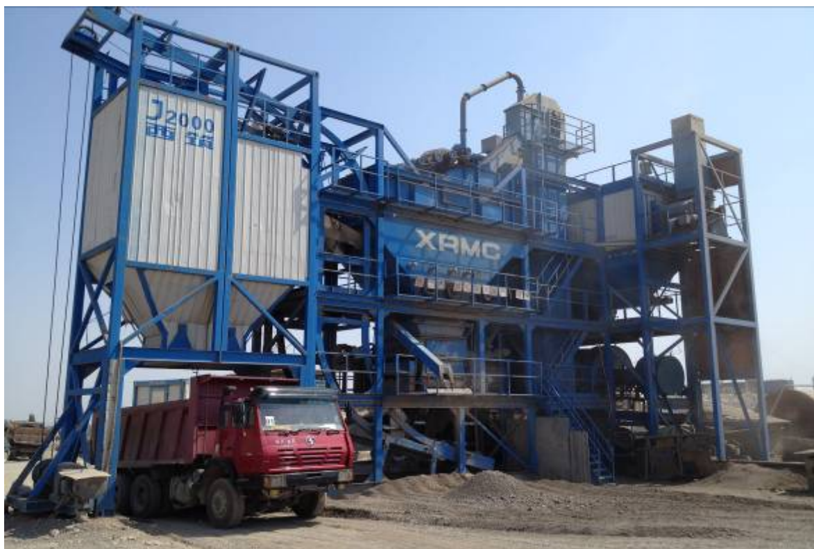
Асфальтобетонный смеситель на км 132+700 ПС
