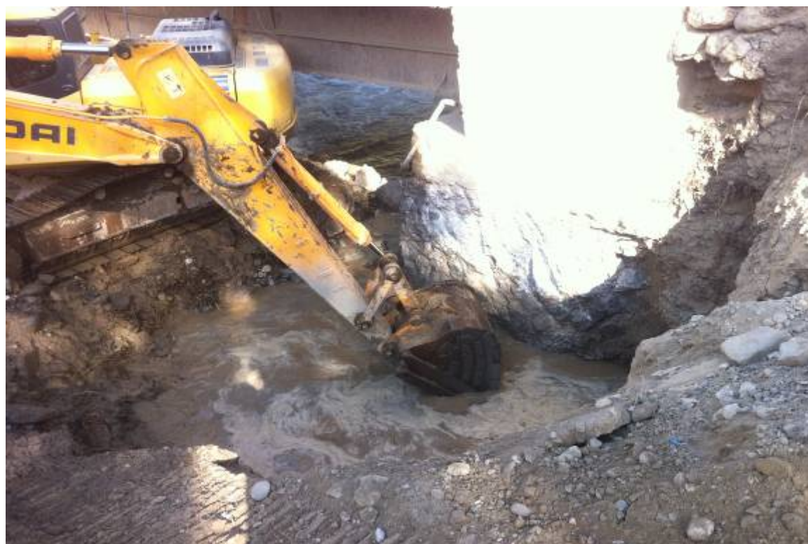
Экспериментальная для опоры моста на км 124+220 ЛС
