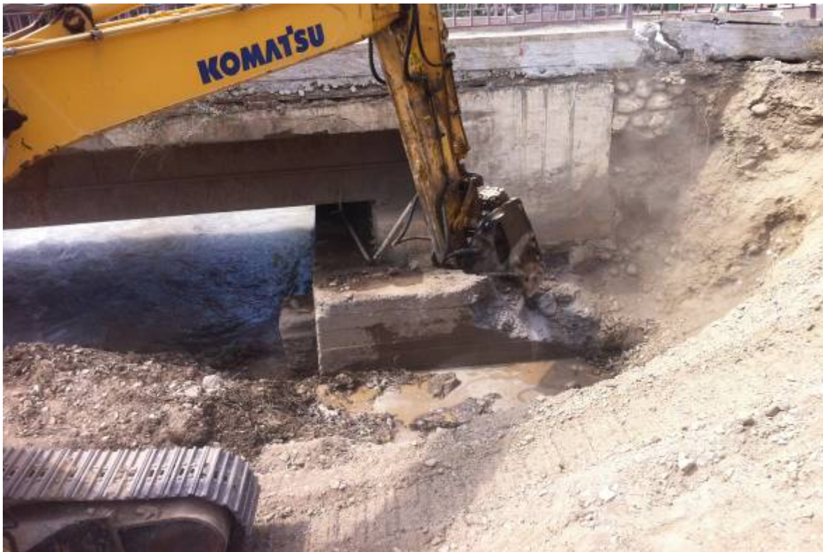
Частичное удаление основания существующей бетонной опоры моста на км 124+220 ЛС
