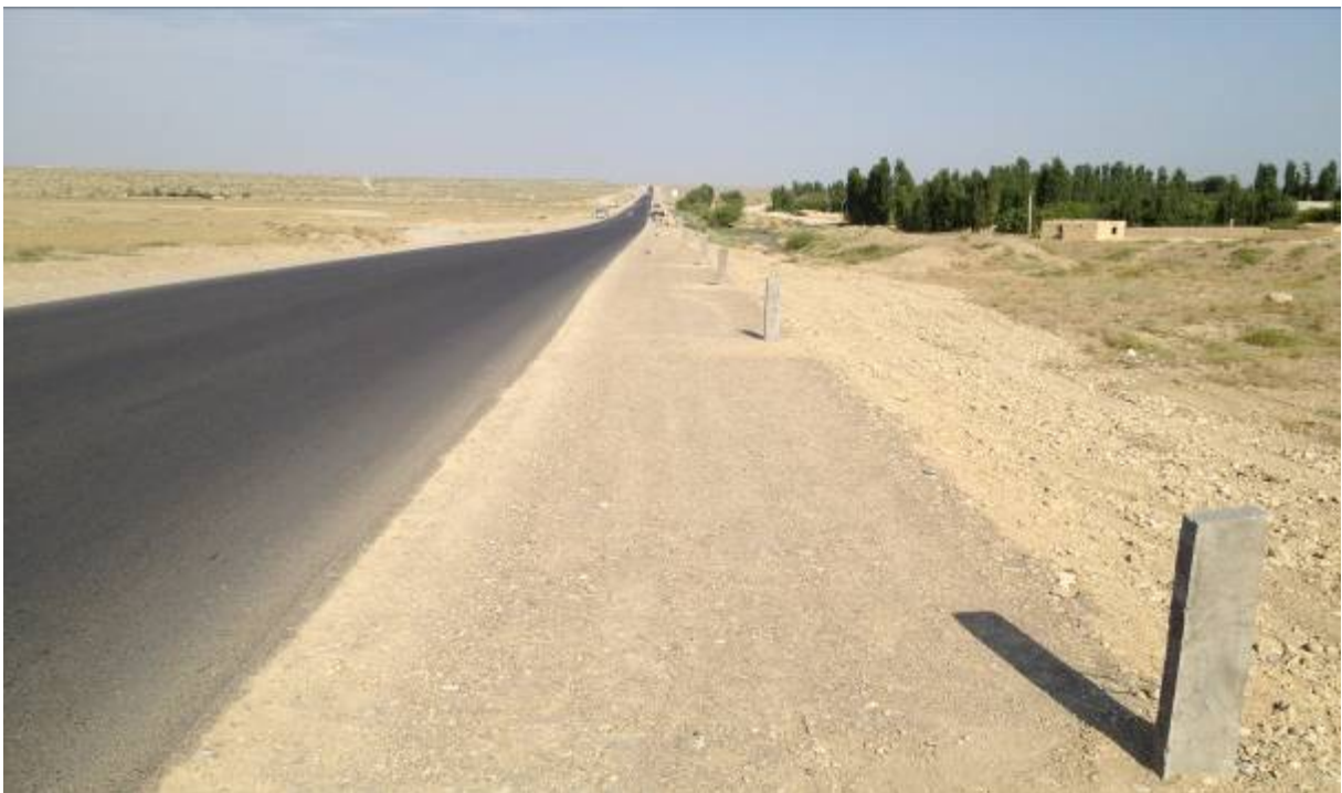
Обеспечение сигнального поста на км 142+200 ЛС
