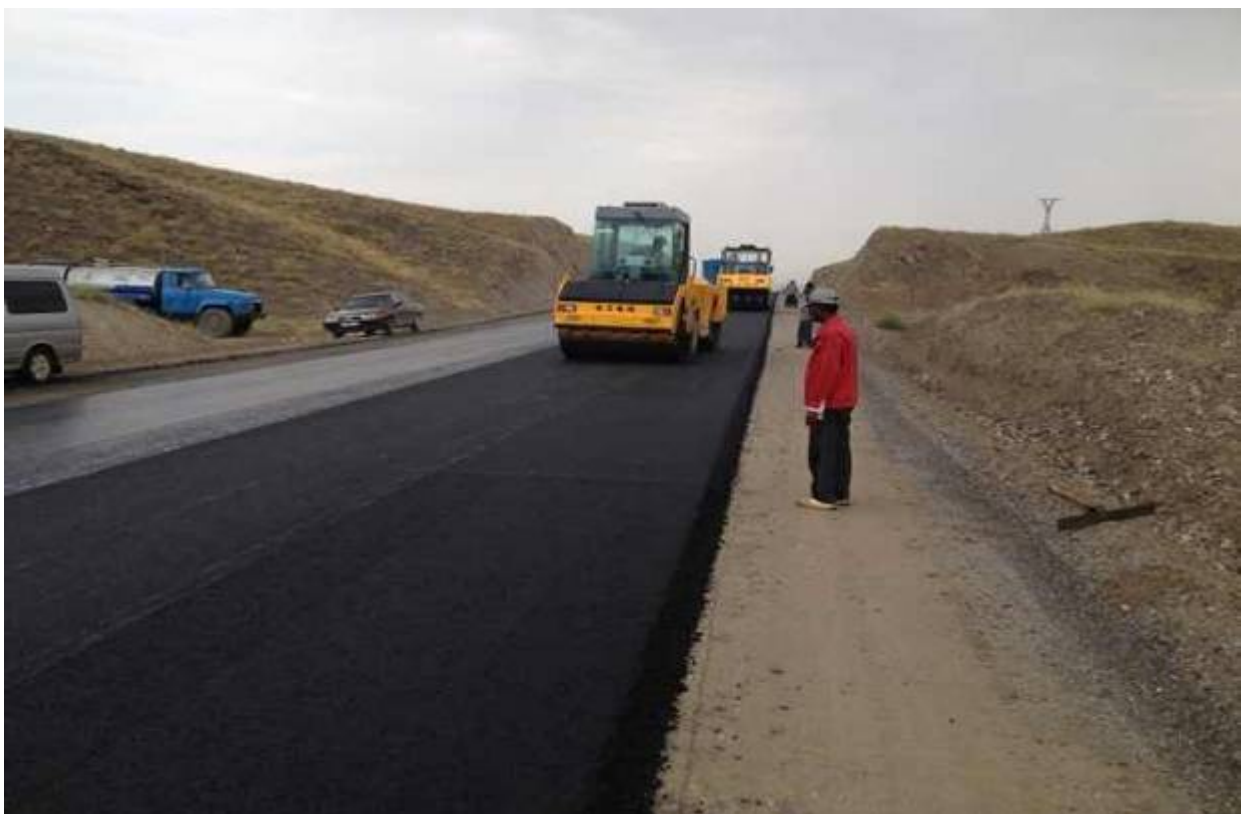
Уплотнение слоя износа на км 129+500 ПС
